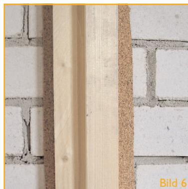
Legen Sie einen Streifen Trittschalldämmung unter den Wandanschluss (Bild 6).
