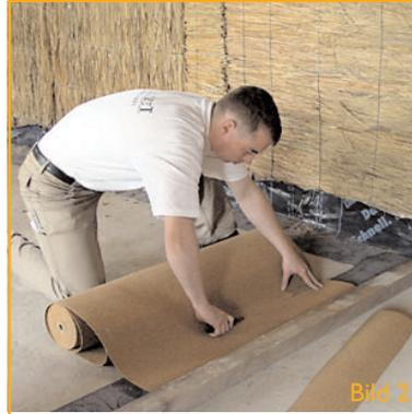
und darüber einen Streifen Trittschalldämmung auf den Boden (Bild 2).
