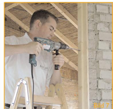
Bohren Sie nun in einem Abstand von ca. 70 cm durch den Wandanschluss in die Wand (Bild 7).
