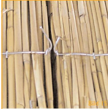
und biegen den durchtrennten Draht nach oben (Bild 15).
