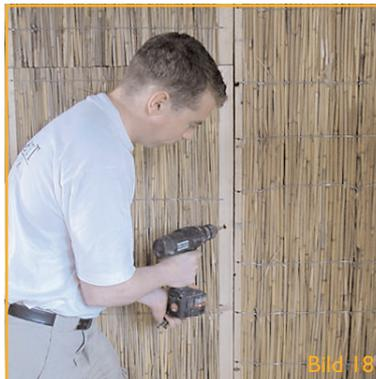
Stellen Sie nun das Wandelement passend an das zuvor aufgestellte. Verschrauben Sie durch die vorgebohrten Löcher das Wandelement mit dem vorigen Wandelement und dem Wandabschluss (Bild 18).
