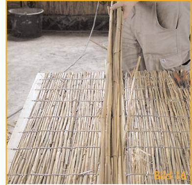
Entnehmen Sie den so entstandenen Wandelementhälfte nun das überflüssige Reet (Bild 16). Achten Sie darauf, dass Sie an den zu verbindenden Schnittstellen der Wandelementhälfen die Drahtklammern nicht herausnehmen, da Sie sonst Probleme beim Zusammenfügen der Wandelementhälfen bekommen werden.
