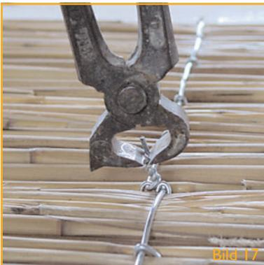
Fügen Sie die beiden Wandelementhälfen wieder zusammen, verdrehen Sie dabei mit Hilfe der Kneifzange die beiden nach oben gebogenen Drähte miteinander (Bild 17).
