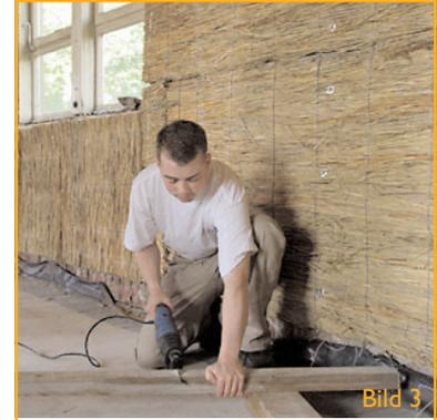
Längen Sie nun die Dachlatte gemäß des angezeichneten Verlaufs ab (Bild 3).
