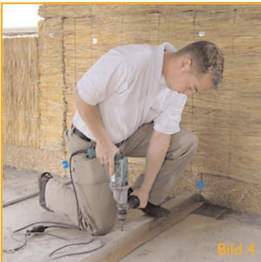
Legen Sie nun die Unterlatte auf die Trittschalldämmung. Befestigen Sie die Unterlatte auf dem Untergrund. Bohren Sie dazu in einem Abstand von ca. 70 cm durch die Latte in den Fußboden (Bild 4) und befestigen die Latte mit Schrauben und Dübeln.
