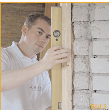
Längen Sie den Wandanschluss passend ab (Maß Oberkante Unterlatte – Unterkante Oberlatte). Befestigen Sie den Wandanschluss lotrecht an der Wand (Bild 5).
