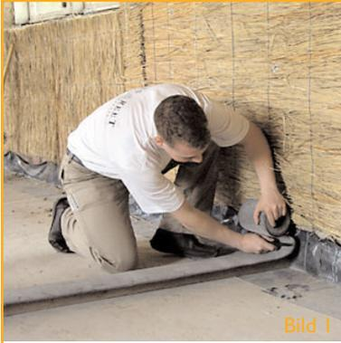
Legen Sie gemäß des Verlaufs der geplanten Wand zuerst einen Streifen Teerpappe (Bild 1)
