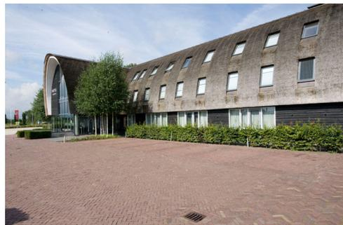
Das rund geformte Dach stellte besondere Anforderungen an den Reetdecker, weil das Reet besonders kurz geschnitten und mit großem Aufwand in die richtige Form gebracht werden muss. (Fotos Hiss Reet)
